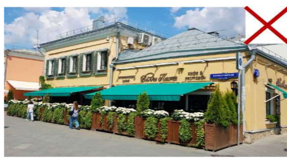
Глухое ограждение и слишком большая маркиза загромождают пространство.
