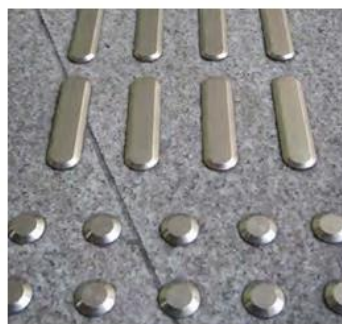
Элементы металлических тактильных указателей
